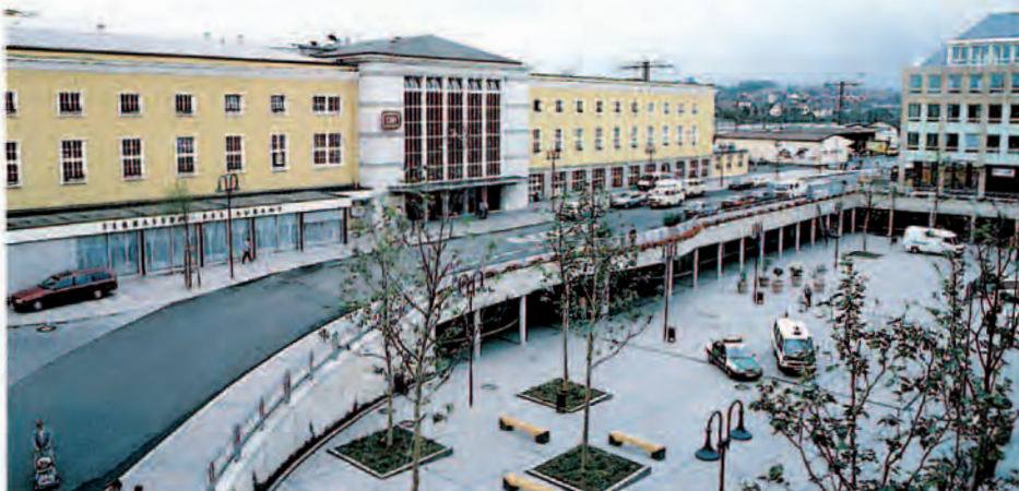
Bahnhof Fulda — der Fußgängervorplatz in Fortsetzung der innerstädtischen Fußgängerzone und die aufgeständerte Vorfahrt
