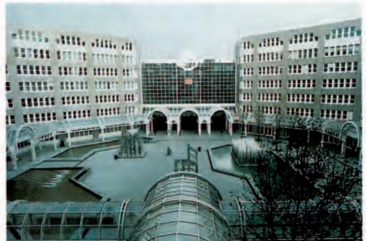
Düsseldorf Hbf — der neue Bahnhofsvorplatz auf der Ostseite für Fußgänger mit dem Parkhaus über dem Bahnhofseingang
