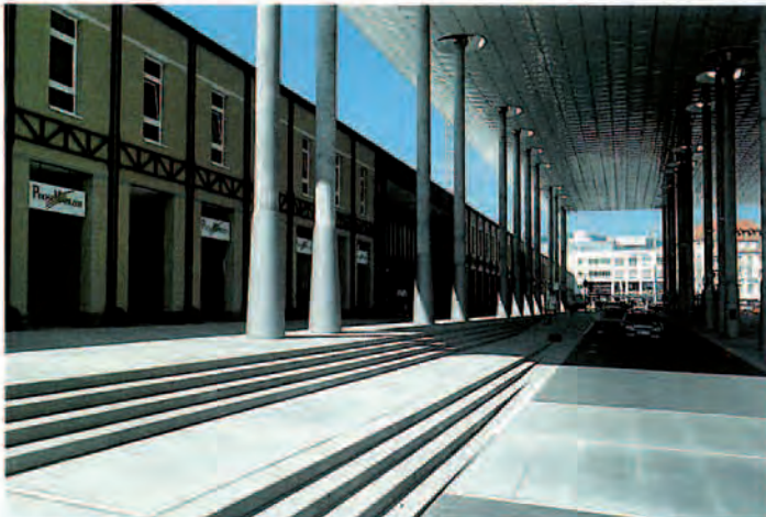
Bahnhof Kassel-Wilhelmshöhe — der überdachte Bahnhofsvorplatz als Verknüpfungszone des Öffentlichen Personennahverkehrs
