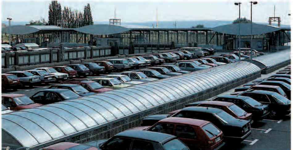
Bahnhof Kassel-Wilhelmshöhe — der Kundenparkplatz über den Bahnsteigen
