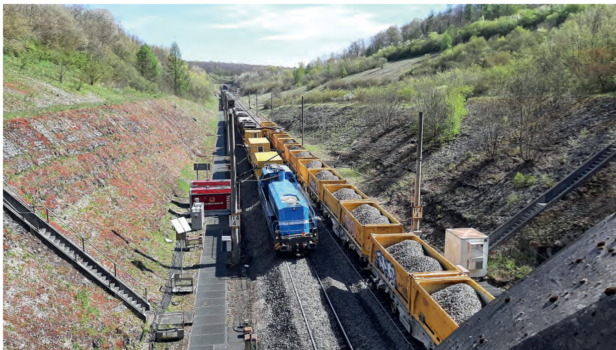
Streckensanierung Hannover – Würzburg: über 93 000 t Schotter wurden erneuert (Foto: Spitzke)
