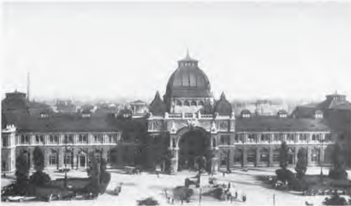
Bild 8: Bahnhof Nürnberg Hbf, 1906
