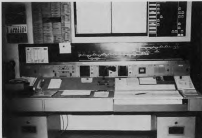
Streckentafel für zentralisierte Regelung der Zugfolge durch den Zugleiter mittels Zugleitfunk
