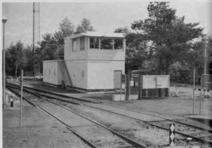
Zugleitstelle mit ortsfester Sender-Empfangsanlage für den Funk-sprechverkehr
