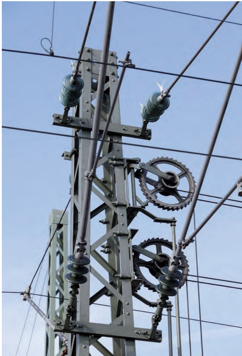
Radspanner halten das Kettenwerk auch bei Temperaturschwankungen straff
