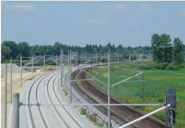
Die Mastabstände sind auf die Oberleitungsbauart und Gleisgeometrie abgestimmt
