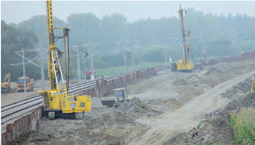
Herstellung der Rüttelstopfsäulen zur Bodenstabilisierung im Bereich der Moorstelle 1 in Haspelmoor
