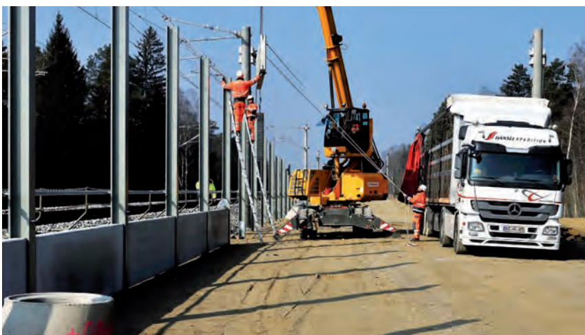
April 2011: Mit gutem Wetter geht es bei der Fertigstellung der Schallschutzwände schneller voran
