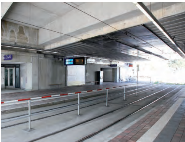
Die Zugänge zu den Bahnsteigen sind in die Widerlager der Eisenbahnüberführung integriert
