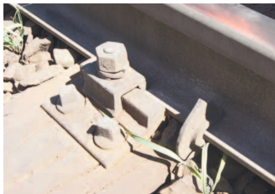
Abb. 2-38: Wanderschutzklemme „Fair“ im Einsatz bei Betonschwellen
