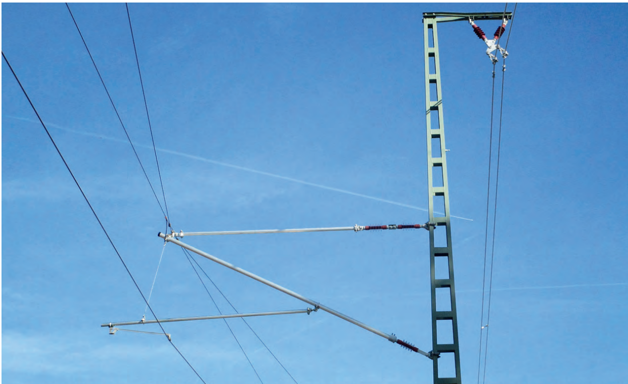
Bild 1: Kettenwerk freie Strecke, im Radius ohne Y-Beiseil
