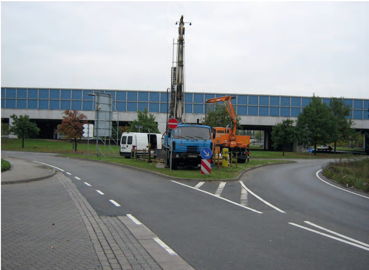
Kernbohrung am Kreisel Unterschweinstiege
