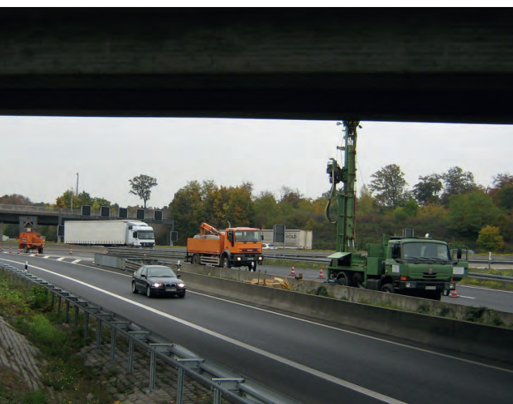
Kernbohrung am Frankfurter Kreuz auf der BAB A 5
