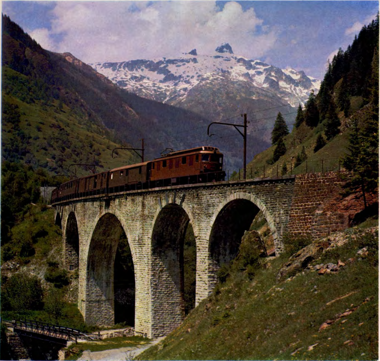
Bild 7. Lonzaviadukt unterhalb Goppenstein (Südrampe) (Zug mit Ae 4/4-Lokomotive Serie 251)
