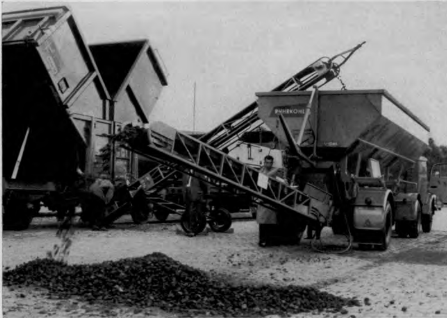
Bild 5. Selbstentladung und mechanische Ladehilfe bei Schüttgütern
