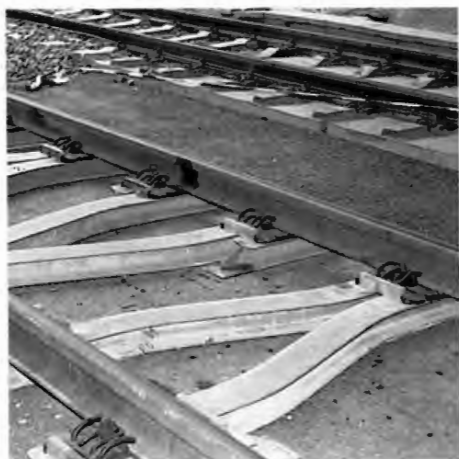
Neue Oberbauformen: Unten Y-Stahlschwellen, oben Oberbau der Bauform „Rheda“
