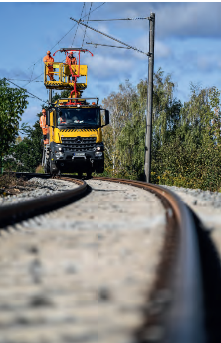
Bild 2: Oberleitungsarbeiten
