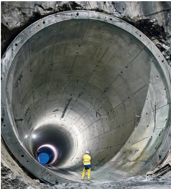
Bild 1: Der maschinelle Tunnelbau meistert schwierigste Herausforderungen, wie hier beim Hallandsås-Eisenbahntunnel in Schweden. Alle Bilder Herrenknecht AG
