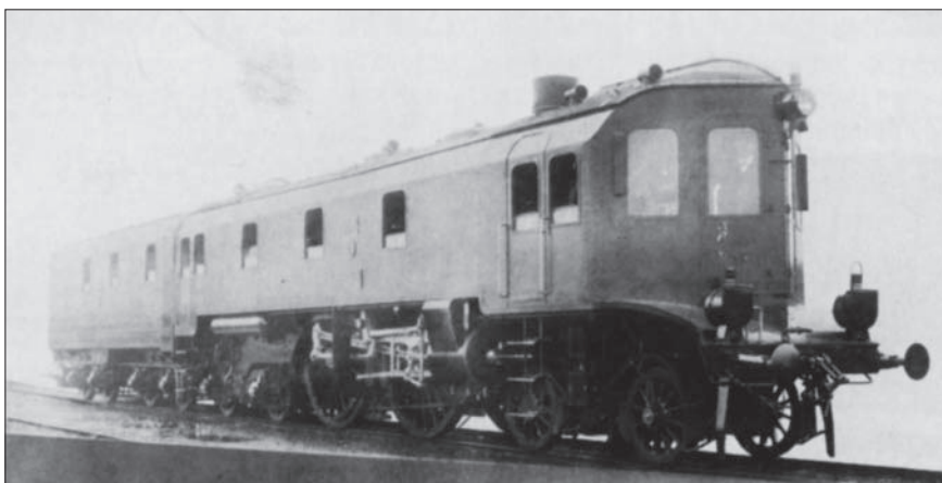
Bild 4: Die Kuhn-Wittfeld-Schnellfahrlokomotive S 9 der preußischen Staatsbahn von 1904 erreichte im Test vor leichtem Zug 137 km/h [3]
