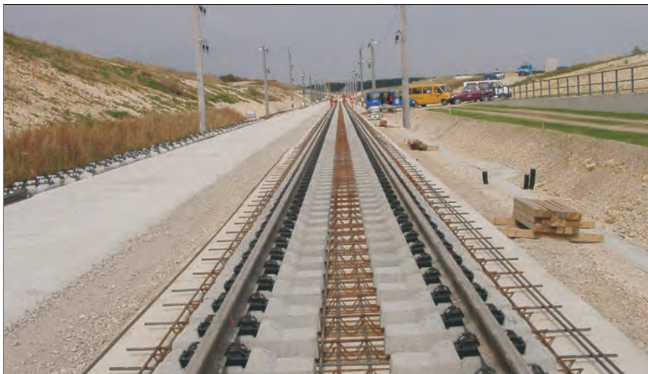
Bild 1: Ansicht Feste Fahrbahn Rheda 2000® vor dem Betonieren
