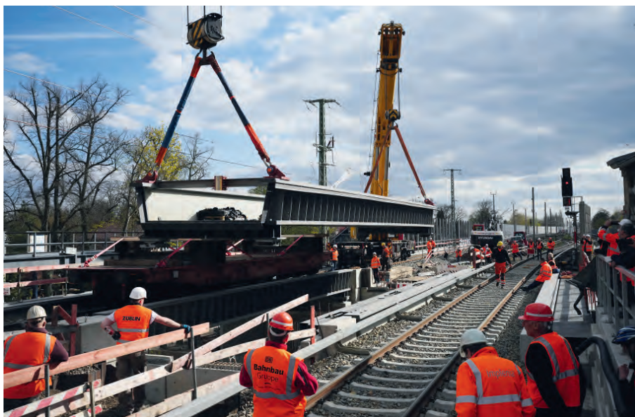
Bild 5: Einhub des innenliegenden Fernbahngleises am Bahnhof Karow im April 2021
