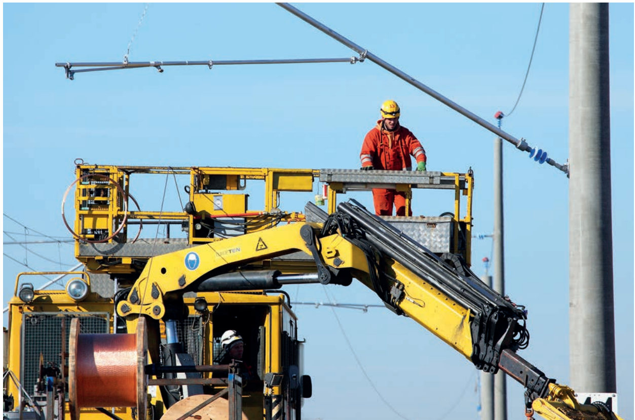
Einbau der Oberleitung
