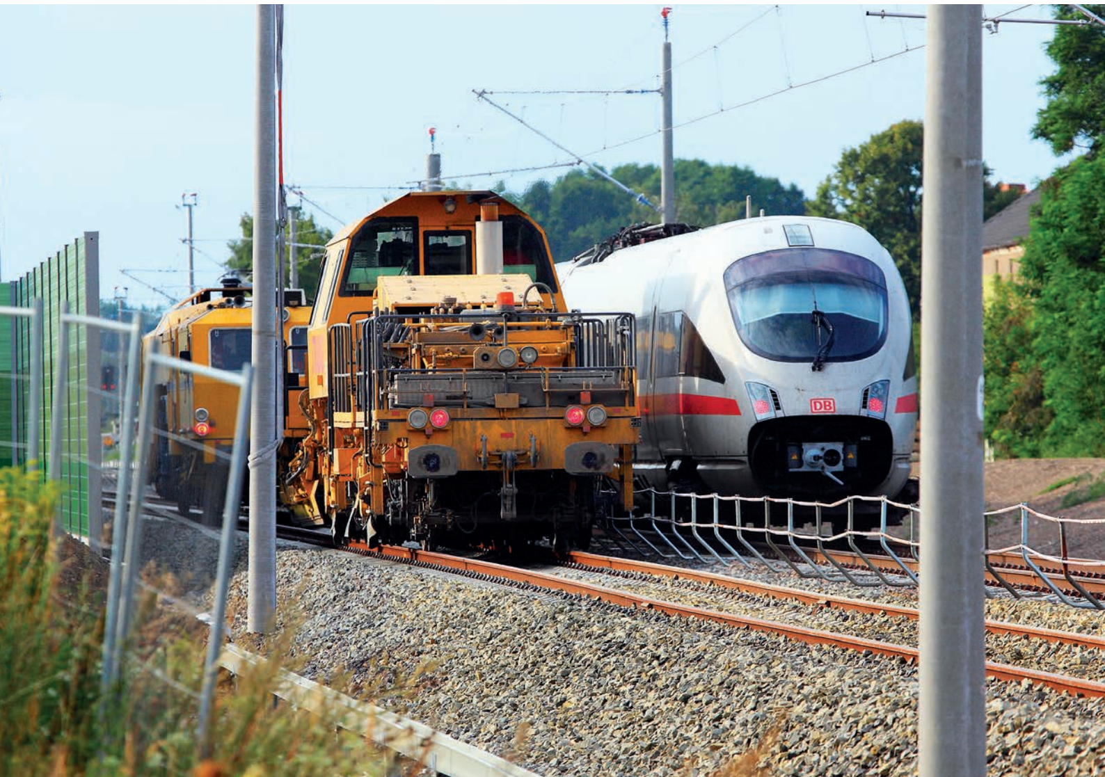
Grüneberg – Gleisstopfmaschine im Bahnhofsgelände, neue Lärmschutzwand links im Bild
