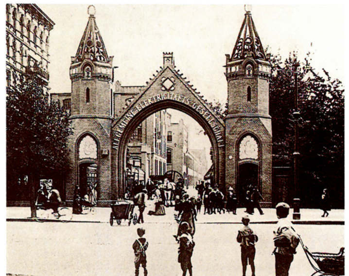
Bild 5: Das berühmte, noch heute existierende Eingangstor der AEG Maschinenfabrik Brunnenstraße, Berlin-Wedding, von 1896. Erbauer: Franz Schwechten
