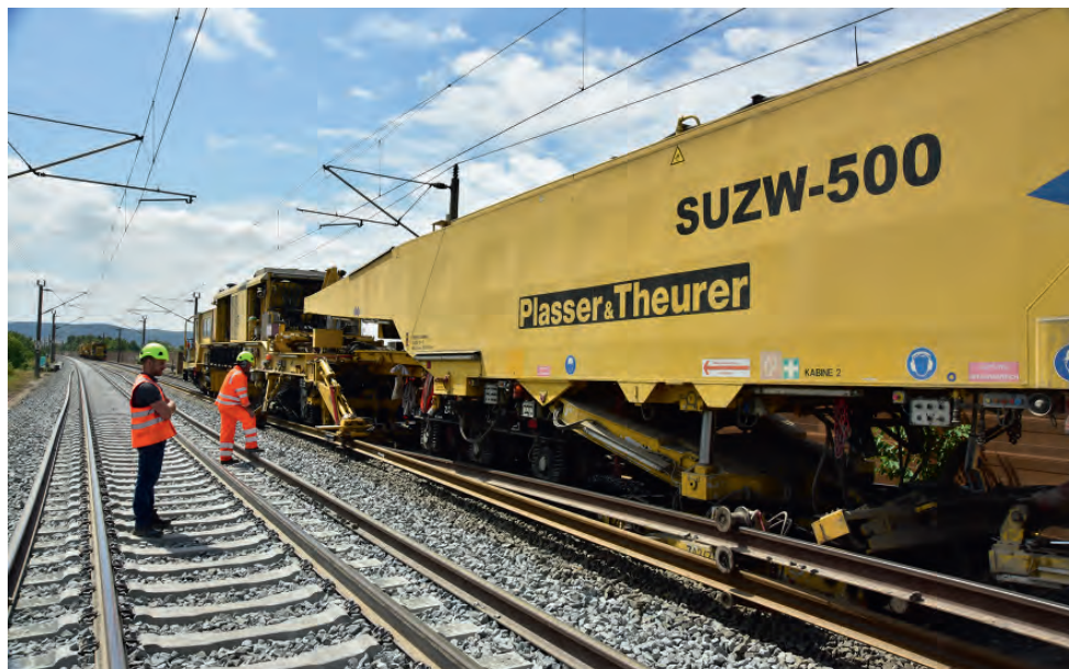
Abb. 3.20: Tausch von Schwellen und Schienen auf der Schnellfahrstrecke unter Vollsperrung, zuvor war das Schotterbett neu aufgebaut worden. Arbeitsrichtung nach links.
