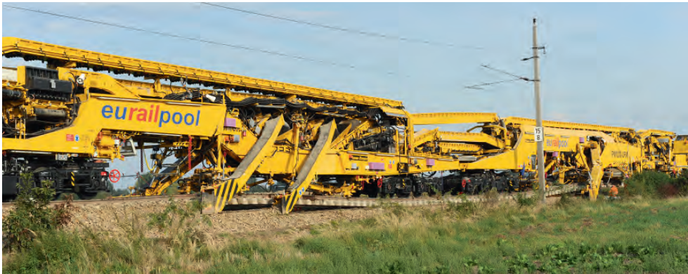
Abb. 3.12: Planumsverbesserungsmaschine im Einsatz. Arbeitsrichtung nach links.
