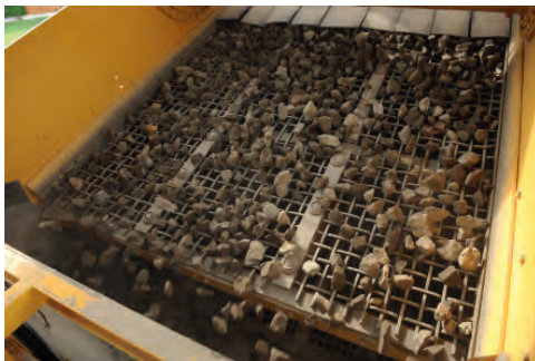
Abb. 3.10: Siebanlage zur Behandlung des ausgebauten Schotters
