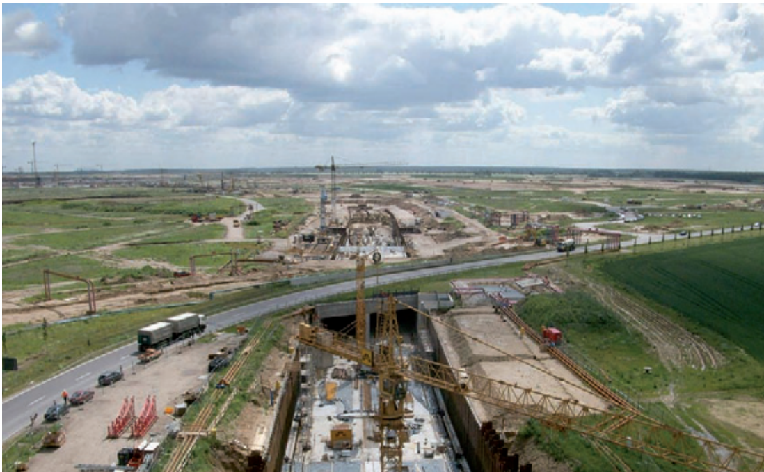
Überblick über einen Teil der Baustelle – Übergang vom Trog zum Tunnel Richtung Flughafen BBI
